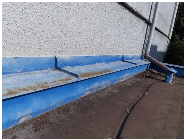
↑Detail oplechování stávající atiky kotelny ←Konec střechy kotelny u zadní části objektu uhelny
